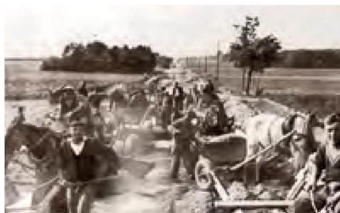
Budowa drogi z Dobrego do Czarnogłowa.
