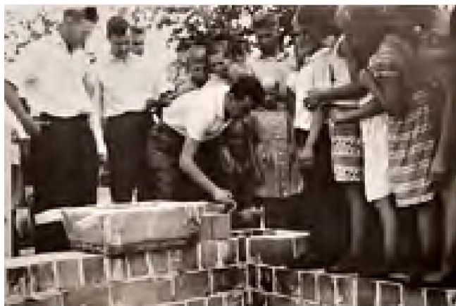
Wmurowanie aktu erekcyjnego w fundament szkoły – 1963 r.
