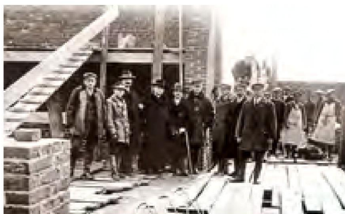
Budowa szkoły w Dobrem – 1935 r.
